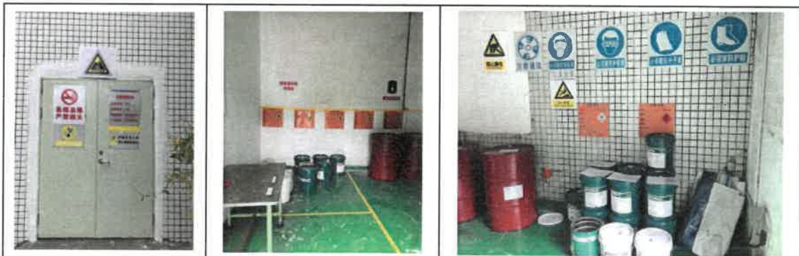
危险废物仓库标识标牌及地面防腐
