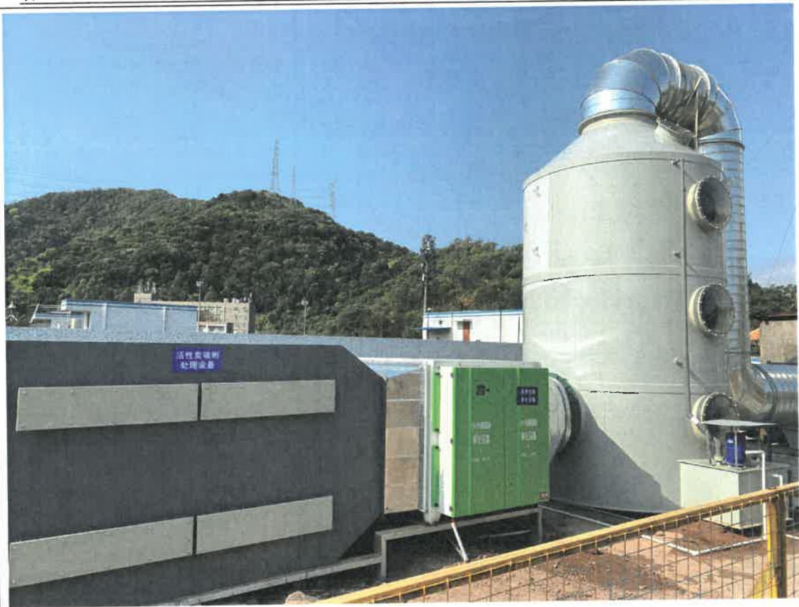
图 3-2 废气处理工艺
