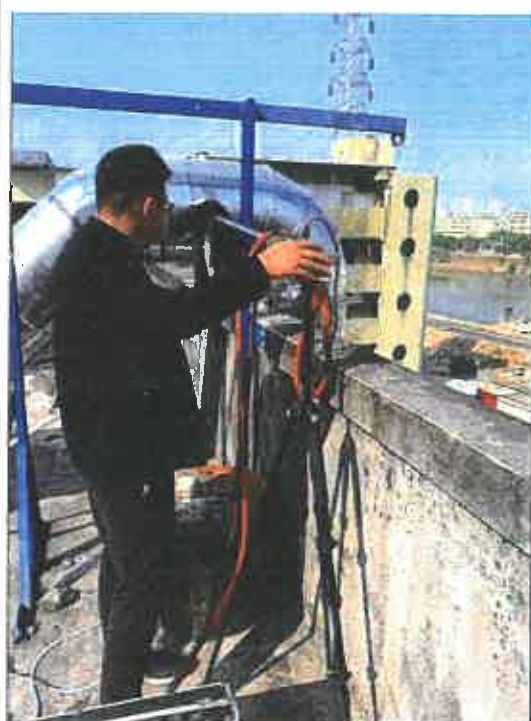
印刷废气处理前检测口（第二天）
