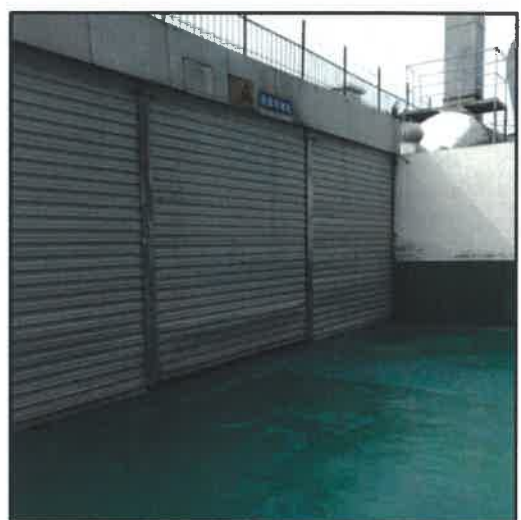
图6 危险废物存储场所（外观）
