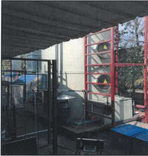
图1 喷漆废气处理塔处理前采样
