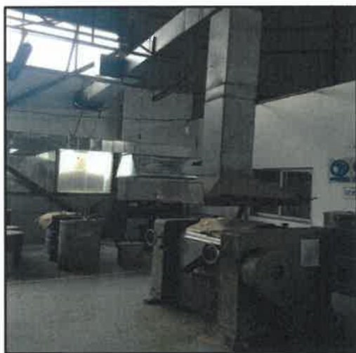
图 3 甲类仓-车间生产照片
